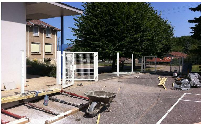
Les travaux de mise aux normes d'accessibilité aux personnes handicapées ont été réalisés au niveau de l'école : création d'un accès pour personne à mobilité réduite, aménagement des sanitaires, modification d'un couloir et sécurisation de l'escalier dans la cour.
