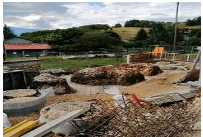
Fondation de la future chaufferie
