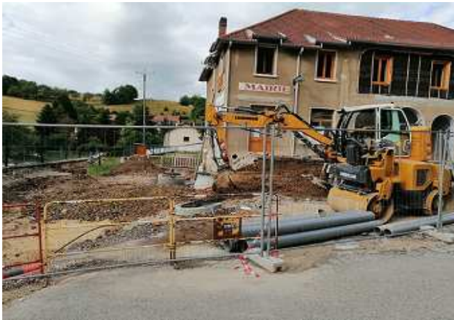
Après la démolition de l'aile Est
