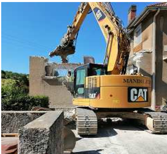
Démolition de l'aile Est
