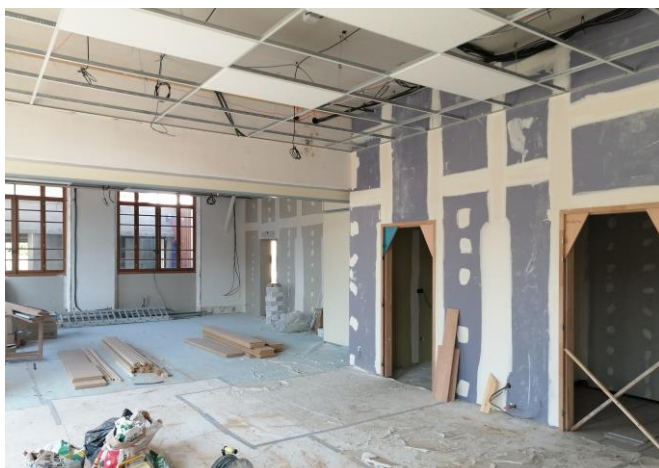
Travaux en cours dans la salle communale
