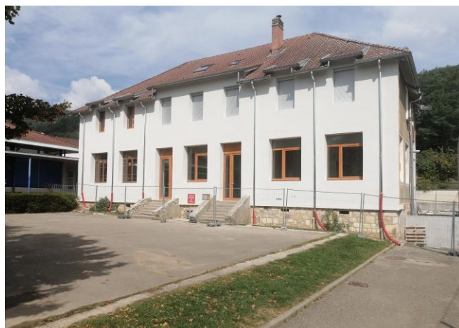
Façade Sud de la Mairie
