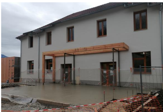
Les travaux sur le parvis de la Mairie
